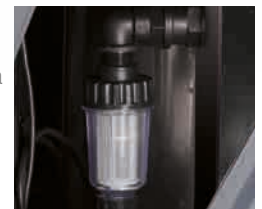
Trappe pratique pour l'inspection et l'entretien du filtre à eau
